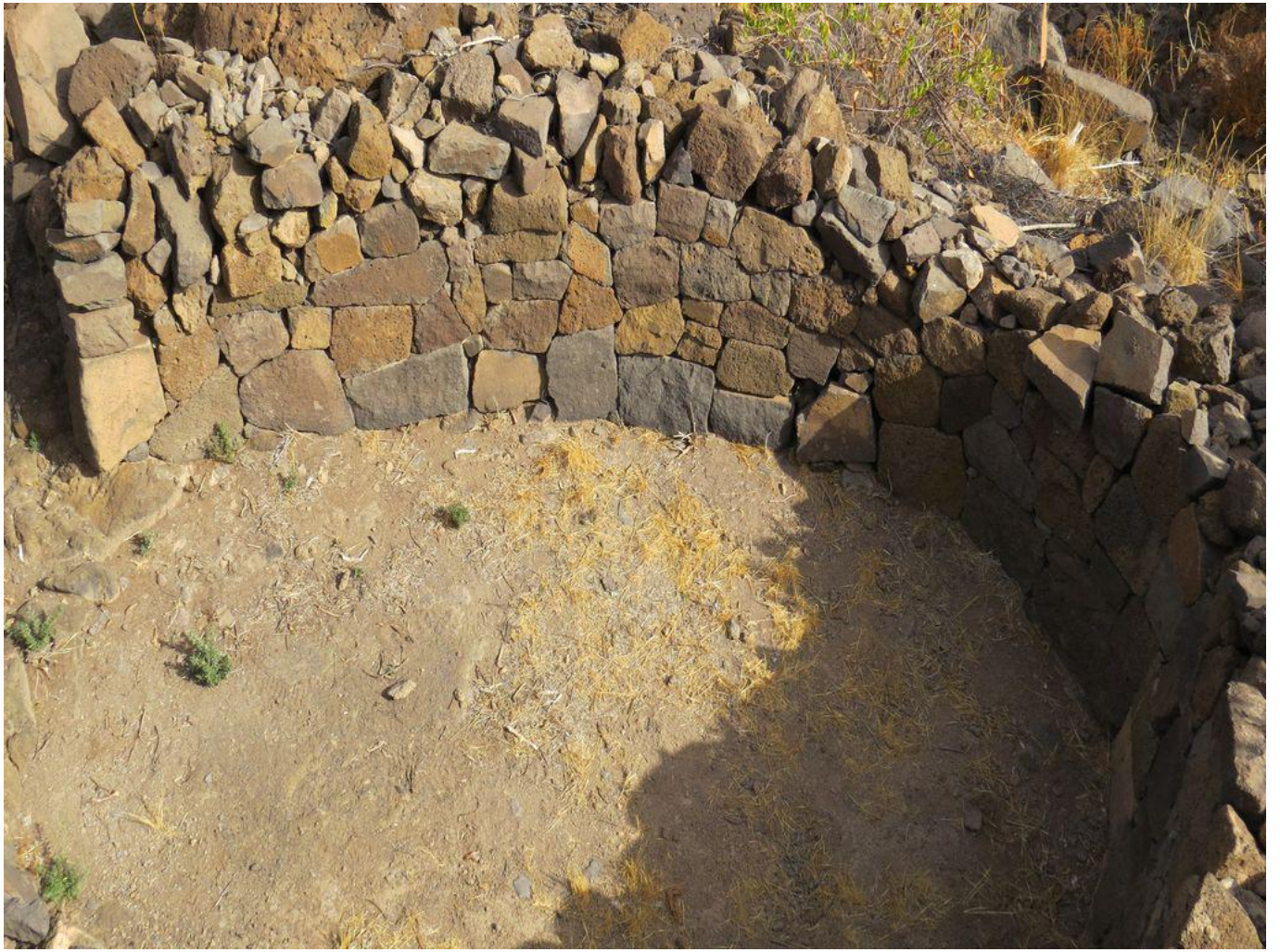
Estructura en la cima
